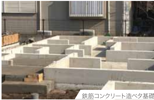
鉄筋コンクリート造ベタ基礎
