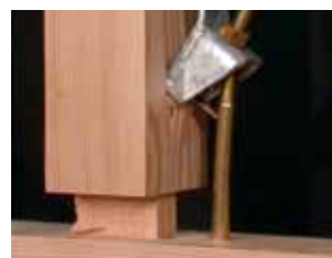
ホールダウン金物 金物が壊れ、柱がほとんど抜けてしまう。
